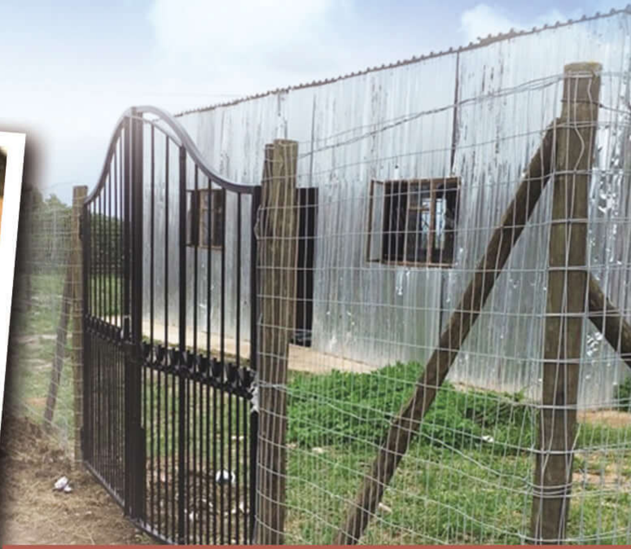
● 近期完成的培训中心围篱工程
